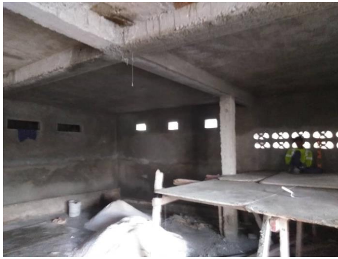
Construction de la cantine de l'école Mounepé (Haïti en Chœur)
