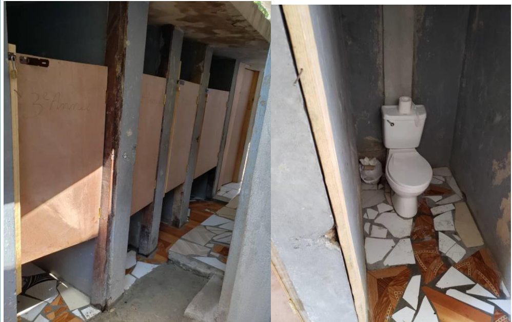
Travaux d'assainissement en cours dans l'école Adrien Masa de l'association Terre de Mission
